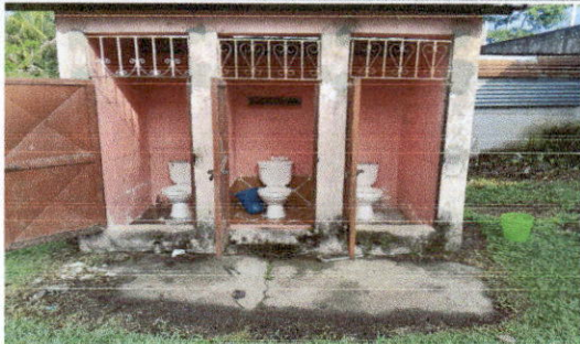
FOTO 1: Mantenimiento a estructura (lijado, cambio de tubo , cepillado, sujeciones, aplicación de pintura)
