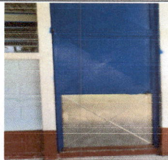
FOTO 4: Mantenimiento a estructura (lijado, cambio de tubo , cepillado, sujeciones, aplicación de pintura) EN AULA
