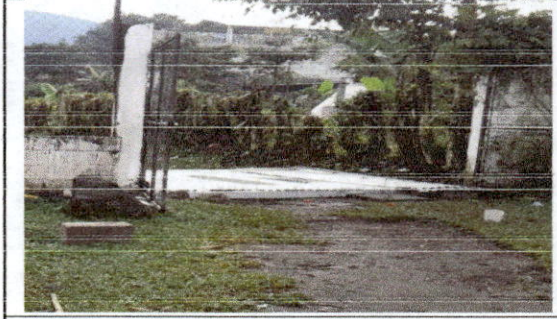
FOTO 7: Mantenimiento a portones de metal PATIO I
