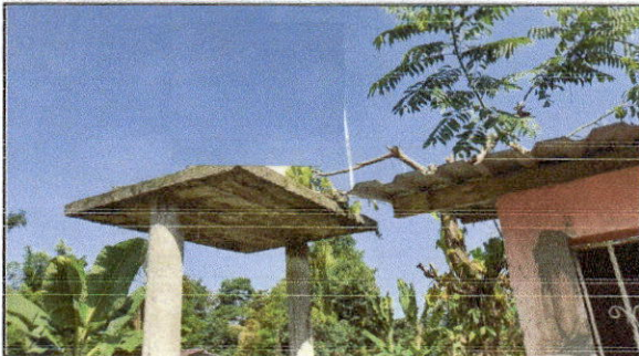
FOTO 3: Sustitución de depósito de agua 1100 lt
