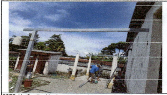
FOTO 11: Sustitución de estructura de soporte de metal, por metal
